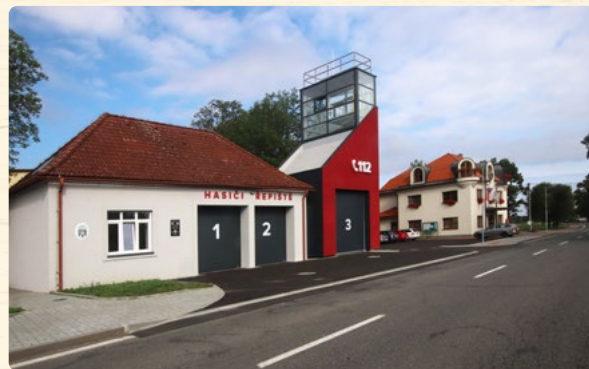
Objekt hasičské zbrojnice postavený v letech 1933–1934, rekonstruovaný v r. 2022. V pozadí objekt obecního úřadu, r. 2022, foto Miroslav Lysek
