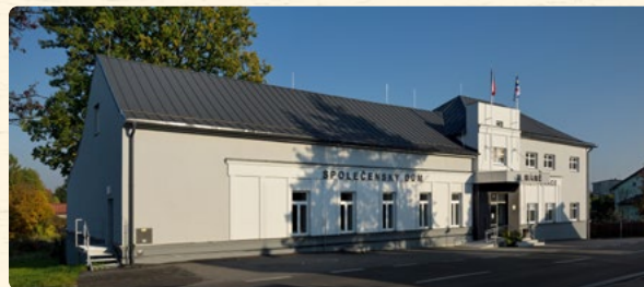
Rekonstruovaný Společenský dům s restaurací U Máně v centru obce, r. 2018, foto Obec Řepiště
