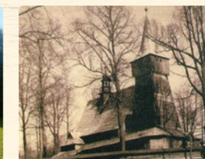
Kościół parafialny p.w. św. Michała Archanioła w Łękawicy w 1930 r., fot. Gmina Łękawica
